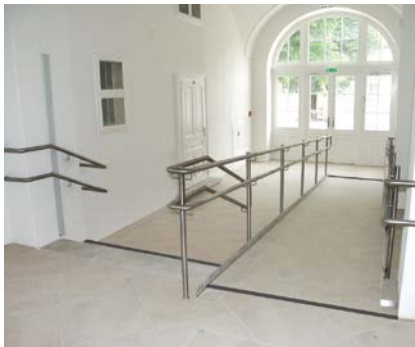
Markierungen an Treppe und Rampe
